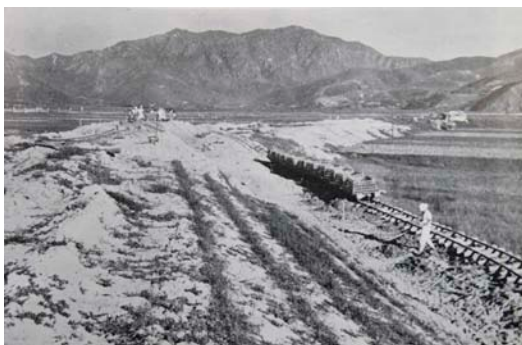
그림 7. 밀성수리조합 남지구 제방 공사
